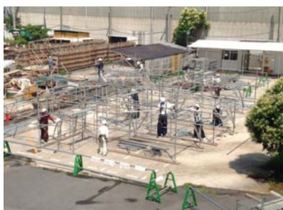
資格取得につながる実習も行っている。写真はとびコースにおける技能士検定対策の実施状況
