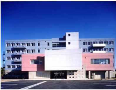
訓練施設は大林組所有の「八潮東ベースハウス(写真)」と「八潮研修センター」を利用している。講義室・実習ヤードとともに、宿泊施設を完備している
