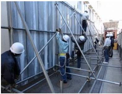
圧倒的な時間が割かれ重視される仮設工事の実習
