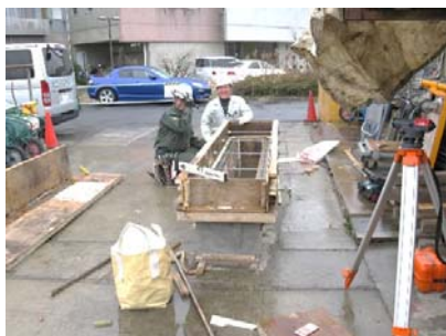
指示通りに設備基礎型枠の建込を練習
