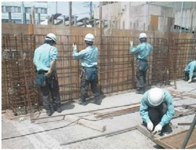
とび・土工、大工、鉄筋の3工種全般を1年間みっちり研修する。写真は鉄筋の実習教育
