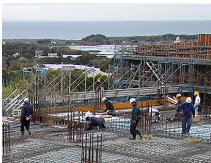
鉄筋工は建物の寿命を左右する骨組みをつくる仕事を行い、大変重要な役割を担っている
