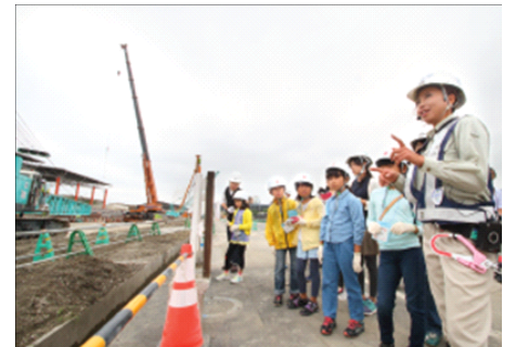
夏休み期間中に、全国 15 箇所で見学会を開催。多くの女性が働いている工事現場を体感した
