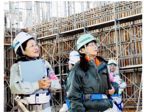
厳しい目線で現場の安全を確認する、女性の会パトロール。
