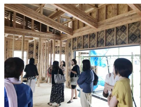
スーパーウォール工法を取り入れた現場を見学
