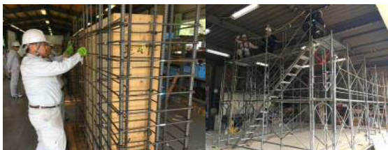
鉄筋組立(兵庫)
