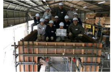
鉄筋・型枠組立完了(静岡)
