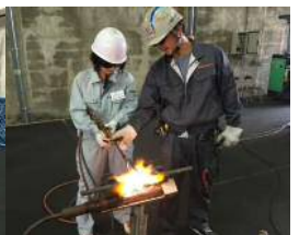
鉄筋圧接(福岡)
