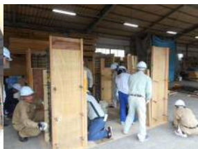
型枠組立(静岡)
