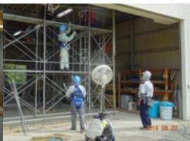
足場組立(兵庫)
