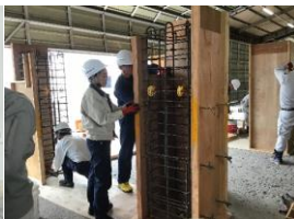
型枠組立(静岡)
