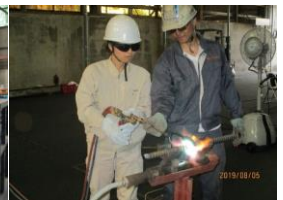
鉄筋圧接(福岡)
