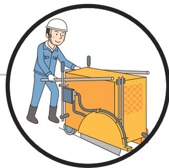
ダイヤモンドの刃物でコンクリートを切断
