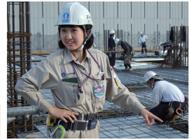
「日々、現場の改善について考えている」と話すなでしこ工事チームリーダーの星野麻夢さん。
