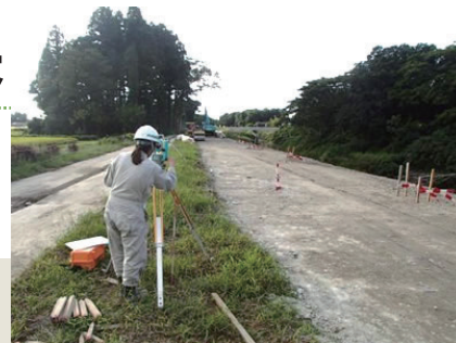
現場で測量を実施する女性技術者
