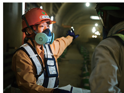
高速道路トンネルの換気所建設工事において、コンクリート工事を担当(当時)している三浦桂子さん
