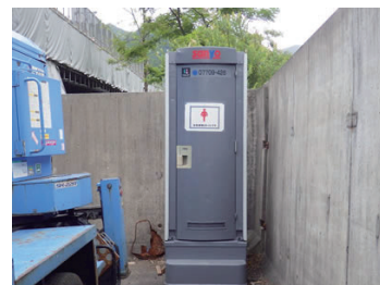
女性技術者のために設置された仮設トイレ
