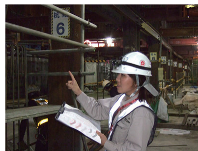
現場で工事の進捗を管理する
