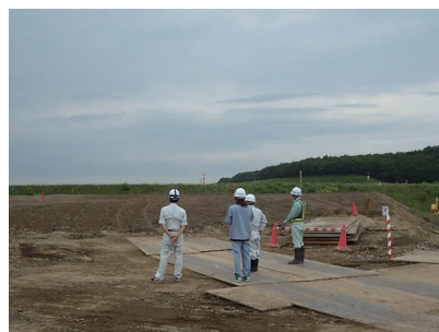
工事現場のパトロールに従事する社員
