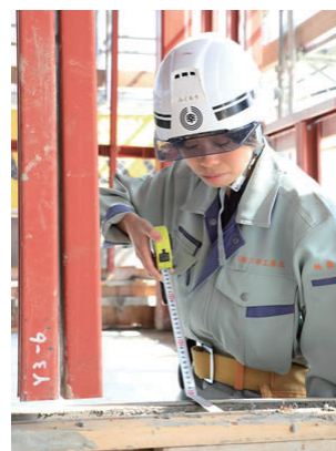
施工状態の確認を実施
