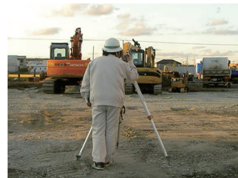
現場にて測量を実施する女性技術者
