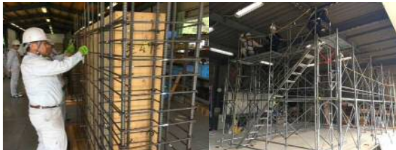
鉄筋組立(兵庫)
