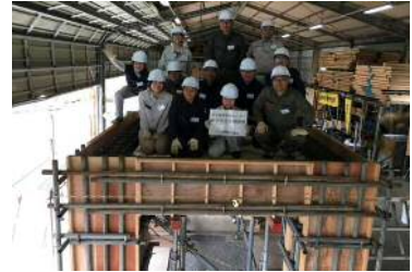
鉄筋・型枠組立完了(静岡)
