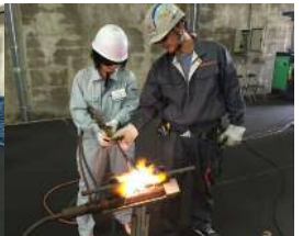
鉄筋圧接(福岡)
