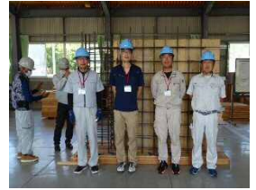
鉄筋組立完了(兵庫)
