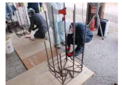
鉄筋組立(静岡)
